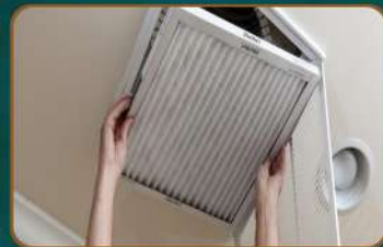
Ensure cleaning of AC filter एसी फिल्टर की सफाई सुनिश्चित करें
